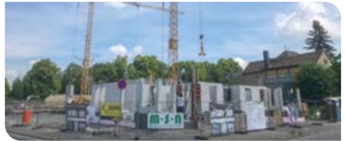
oben: Ausgangszustand vor Baubeginn und aktueller Baustand unten
